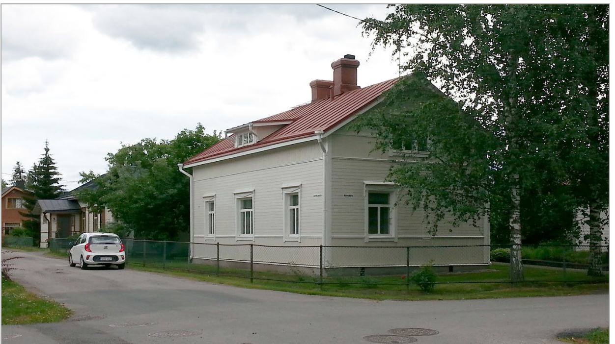
Edellisen viereinen kiinteistö 61-7-32-6 nähtynä Käsityöläiskadun ja Koivukadun risteyksestä.
